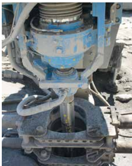
VD100-Bohrung in Granit, 25 m tief, Bohrlochdurchmesser 120 mm, Spülung mit Luft
