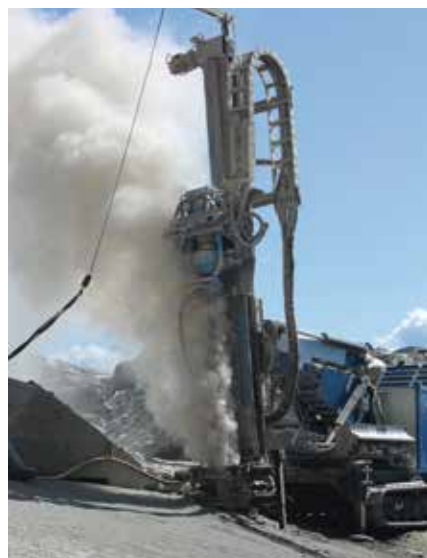
VD100-Bohrung in mittelhartem Gestein, 100 m tief, Bohrlochdurchmesser 135 mm, Spülung mit Luft
