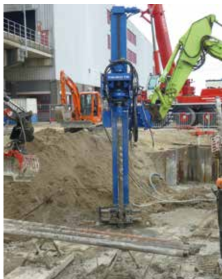
VD100-Bohrung in Sand und Kies, 65 m tief, Bohrlochdurchmesser 190 mm, Spülung mit Wasser
