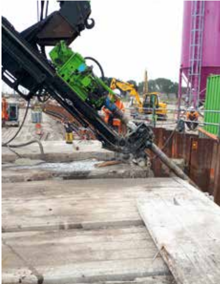
VD150 bohrt 177,8 mm Außenrohre für 60 m lange Litzanker
