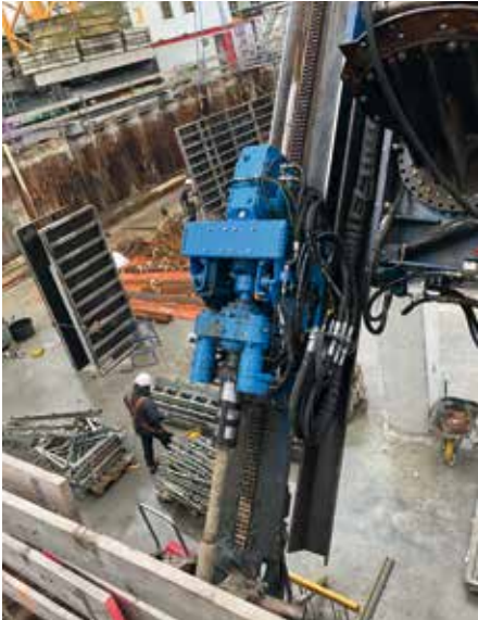
VD150: Ziehen von Selbstbohrankern, 60 m lang
