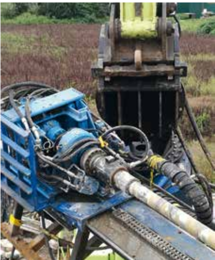
Bohren von 178 mm Rohren in 48 m Tiefe mit verlorener Bohrkron
