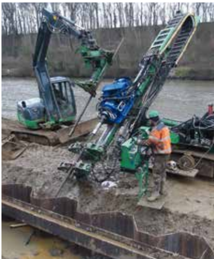
Bohren von 73 mm Selbstbohrankern 65 m tief in Sand und Kies
